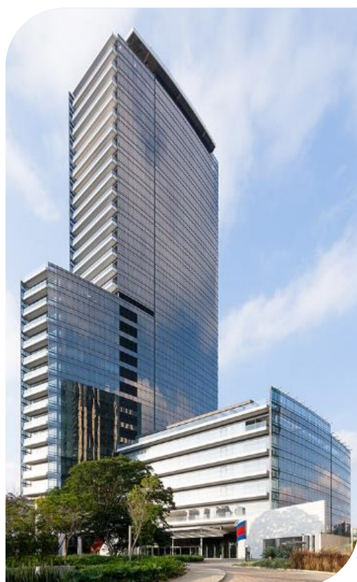
Edifício Berrini One – São Paulo
